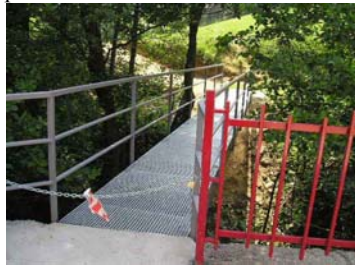
Passarel·la nova, pels TA3 i CC
