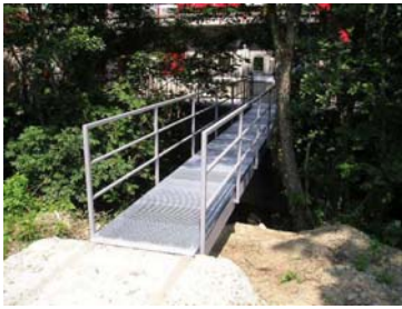
Passarel·la nova, pels TA3 i CC
